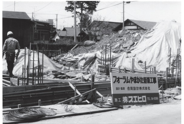
「フォーラム」建設現場 Forum Theater under construction
